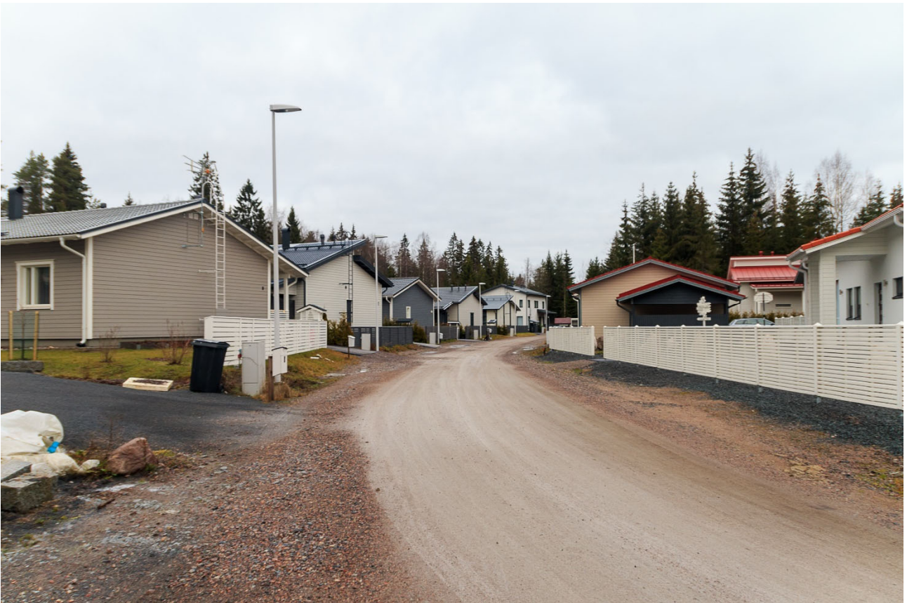
Kuva 3. Urpuntien varren rakentamista. Kaava-alue on kuvan oikealla olevien rakennusten takana.
